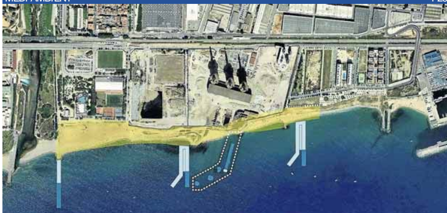
Imatge aèria de l'entorn de les Tres Xemeneies que mostra la situació de l'escull artificial que es vol mantenir ■ EPA
