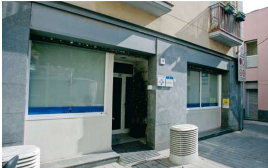
El nuevo servicio está en la calle Riereta
