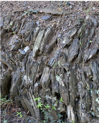
Murs en sec de pissarra en rastrell amb llosa superior col·locada en pla
