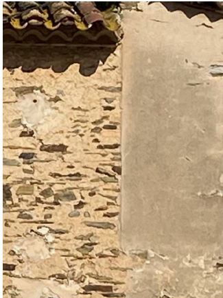
Façana de pissarra i morter. Parcialment arrebossada.
