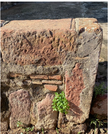
Mur culminat amb pedra basàltica vermella
