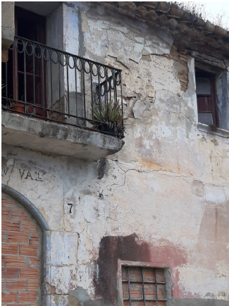
Façana de la masia. Arrebossada i pintada. Marcs a portes i finestres
