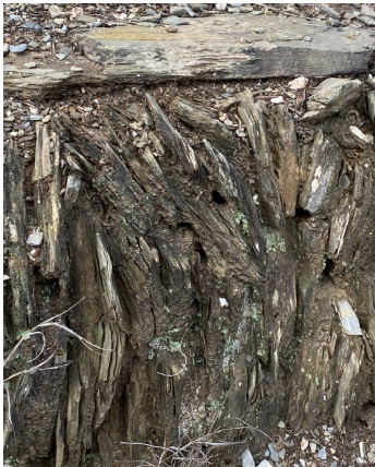
Murs en sec de pissarra en rastrell amb llosa superior col·locada en pla
