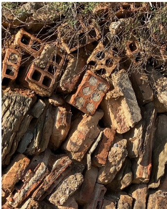
Mur amb totxo perforat, en sec
