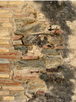
Façana de totxo massís i pissarra. Amb restes d'arrebossat.
