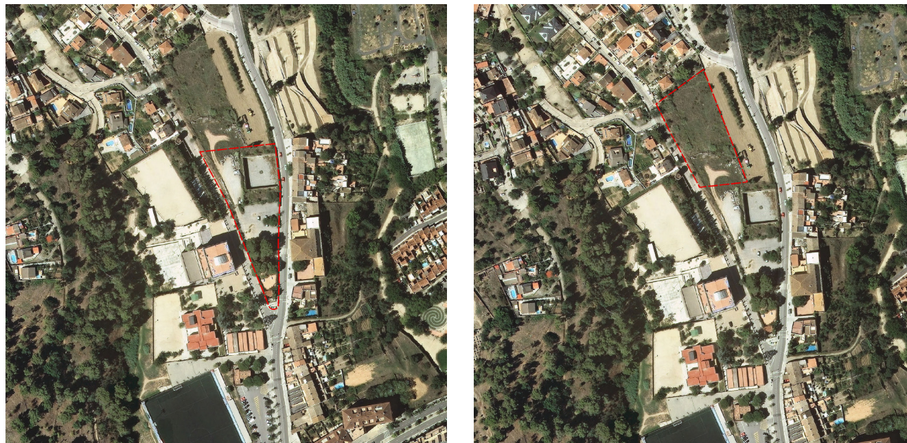
imatge 4.3.1.1: Cruilla Entre El Carrer De Can Paulet I La Carretera De Sant Climent - Ortofoto i àmbit
