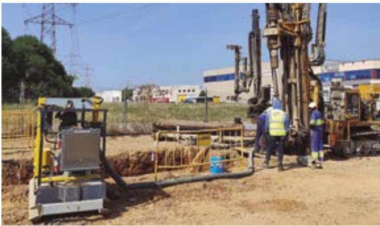
POZO EN CONSTRUCCIÓN. Para ahorrar agua potable en el riego de calles
