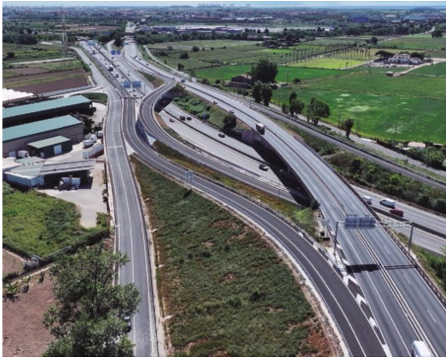
La configuración definitiva del sistema circulatorio en torno a la nueva autovía va tomando forma progresivamente
