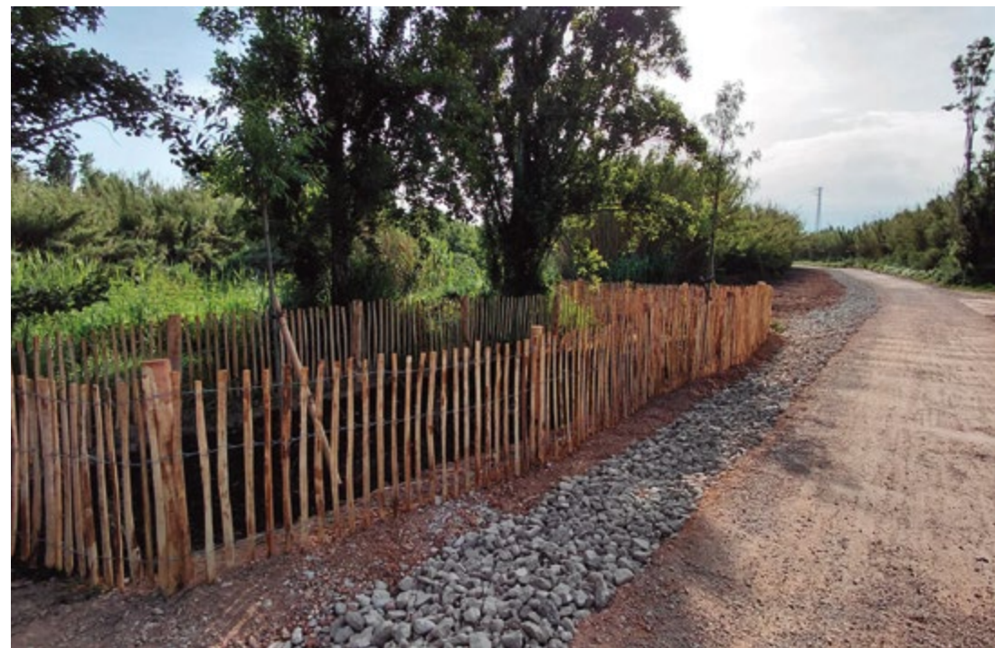
Unas cunetas facilitan que el agua de la lluvia vaya a parar al río
