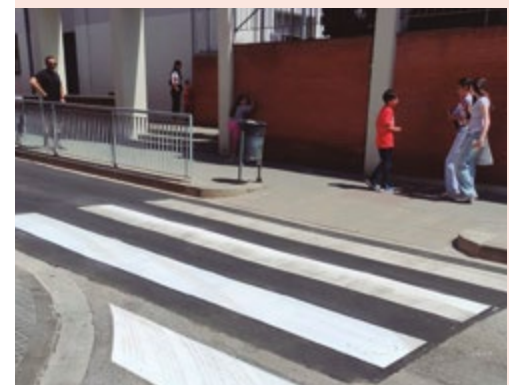
Nuevo paso de peatones en la calle Cerdanya
