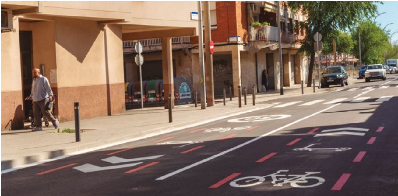
En abril se repavimentó la avenida Onze de Setembre, entre Jaume Balmes y la ronda de Sant Ramon
