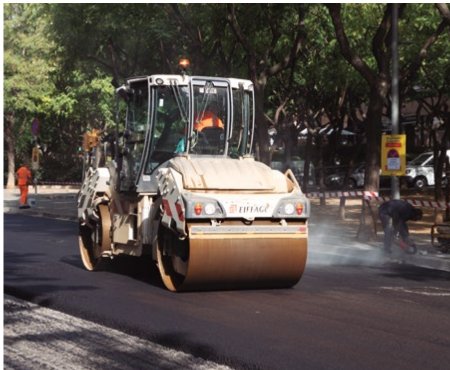
Recientemente se han reasfaltado tres tramos de la calle Girona
